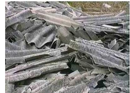
Le lastre in eternit possono rilasciare fibre di amianto se abrase, segate, perforate o spazzolate, oppure se deteriorate. Il problema dell'amianto è quindi legato al rilascio delle fibre; infatti, soltanto fibre con certe dimensioni possono provocare il tumore ai polmoni
