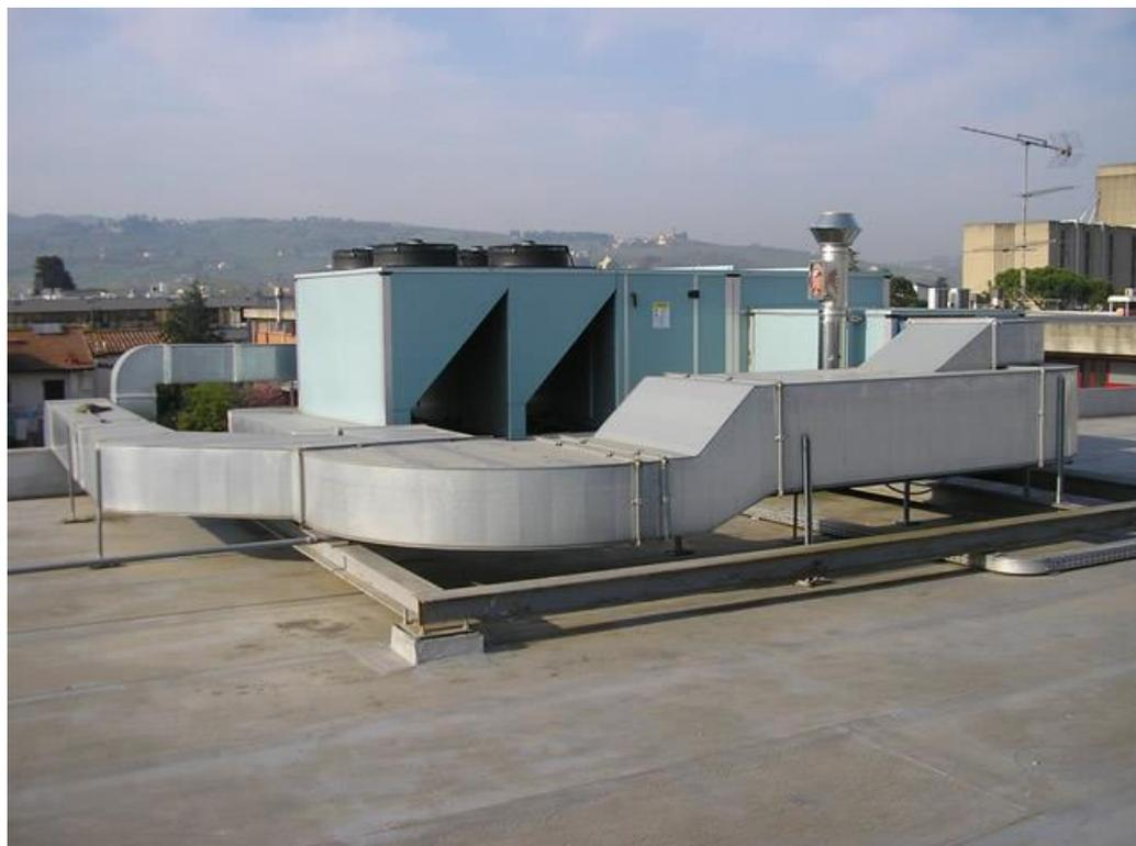
La circolazione dell'aria di raffreddamento del condensatore è assicurata da **uno o due ventilatori elicoidali** posti **nella parte superiore della macchina** con scarico verso l'alto
